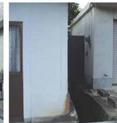
隠された背割水路
